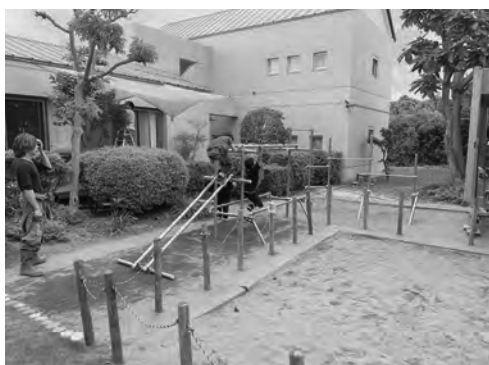
隣の病院が移転し、不要になったパイプをいただいて新遊具に。
